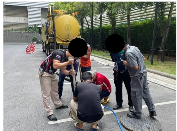
รูปที่ 2-45 ตรวจสอบและทำความสะอาดท่อระบายน้ำบ่อพักน้ำ
