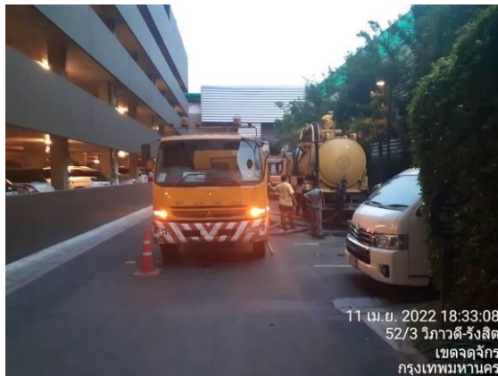
รูปที่ 2-45 ตรวจสอบและทำความสะอาดท่อระบายน้ำบ่อพักน้ำ
